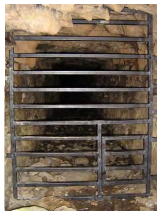
Entrée de galerie bouchée par terrassement en septembre 2013 et exemple de la pose d'une grille sur une entrée de cavité à Bas-en-Basset par le CEN Auvergne. Des travaux similaires seront menés en 2014 à Coucouron.
