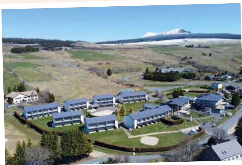
Le VVF avant le chantier.
