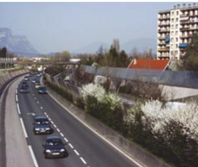
Des murs antibruit permettent de limiter les nuisances sonores pour les riverains proches des axes à grande circulation.
