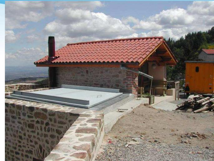
**Le silo avec sa trappe de remplissage.**
