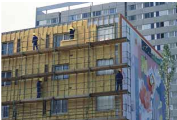
Isolation d'une façade d'immeuble par l'extérieur.
